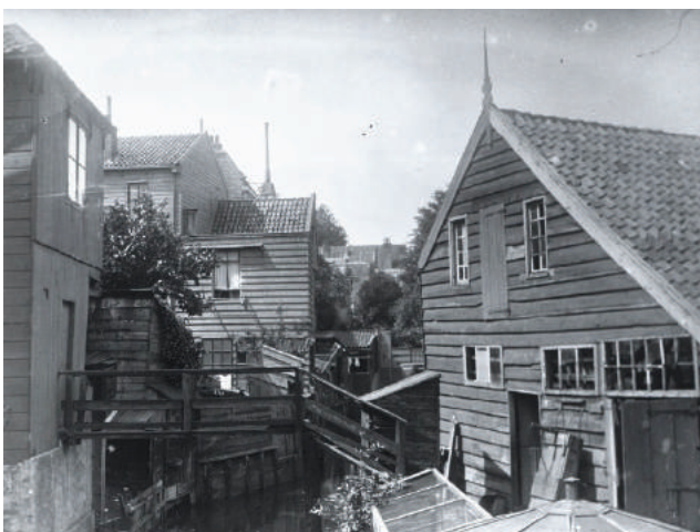
1924 - Achterzijde van de Zuiddijk met de dijkloot. Doordat de Zuiddijk hoger is dan de achterliggende straten, hebben de dijkhuizen een extra verdieping aan de achterzijde. De huizen zijn doorgaans van hout en in typisch Zaanse stijl.
