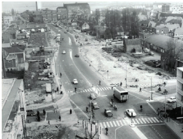
1966 - De 'krakkemikkige' Peperhoek verdween volledig voor de aanleg van de oprit naar de nieuwe Beatrixbrug (1957).
