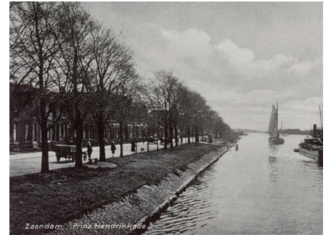
1930 - Na de verhuizing van Pont wordt begin jaren '30 de Comonistenbuurt en Burchtgalerij gerealiseerd. De huizen liggen aan een redelijk smalle kade met mooie bomen langs het water.
