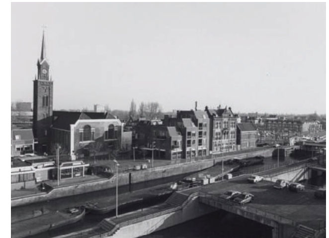
Oostzijde in 1991 - Met de nieuwbouw uit de jaren '70/80 is deels gepoogd om aan te sluiten bij de bestaande korrel. De uitstraling is alleen veel minder. De paviljoens maken de openbare ruimte diffuus. De historie van sluis als hart van het oude Zaandam zie je nergens meer goed terug.
