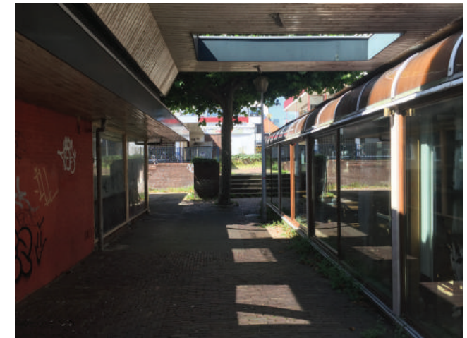
De openbare ruimte tussen de paviljoens is onaangenaam. De luifels van de paviljoens versterken het gevoel van een achterstraatje waar je liever niet komt als het donker is.
