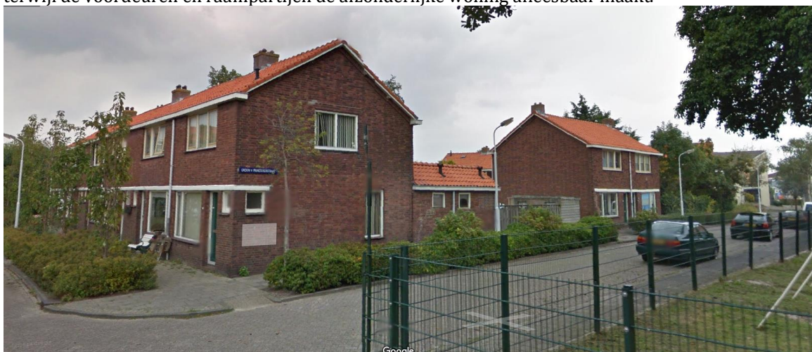
Fase 2, Woningstichting Krommenie, Hoek Talmastraat/Groen van Prinstererstraat, opgeleverd 1938.
