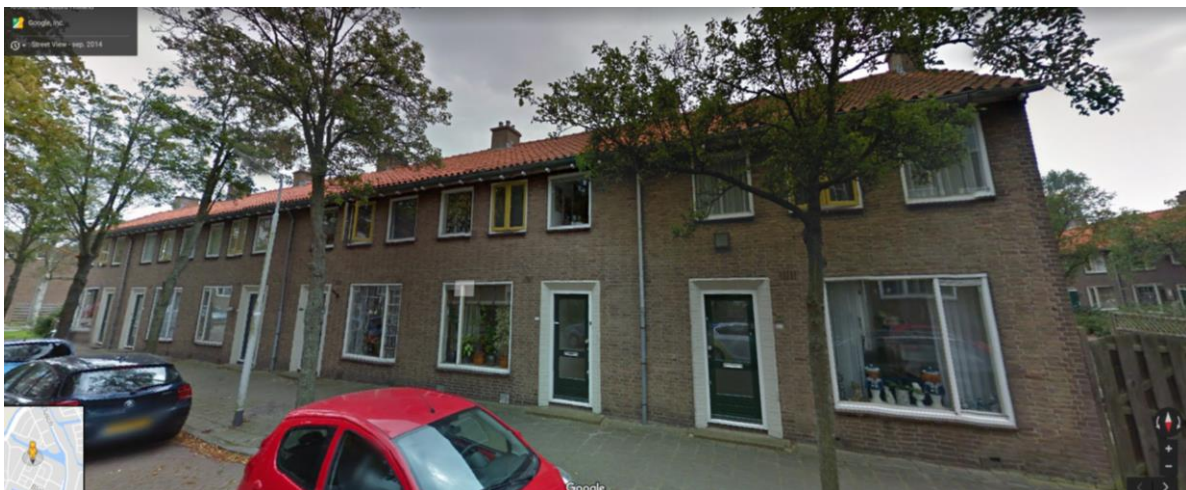
De laagbouw van fase 4, Serooskerkestraat, zorgvuldig ontworpen met dakgoot op houten klossen en gearticuleerde deuroplijsting.
