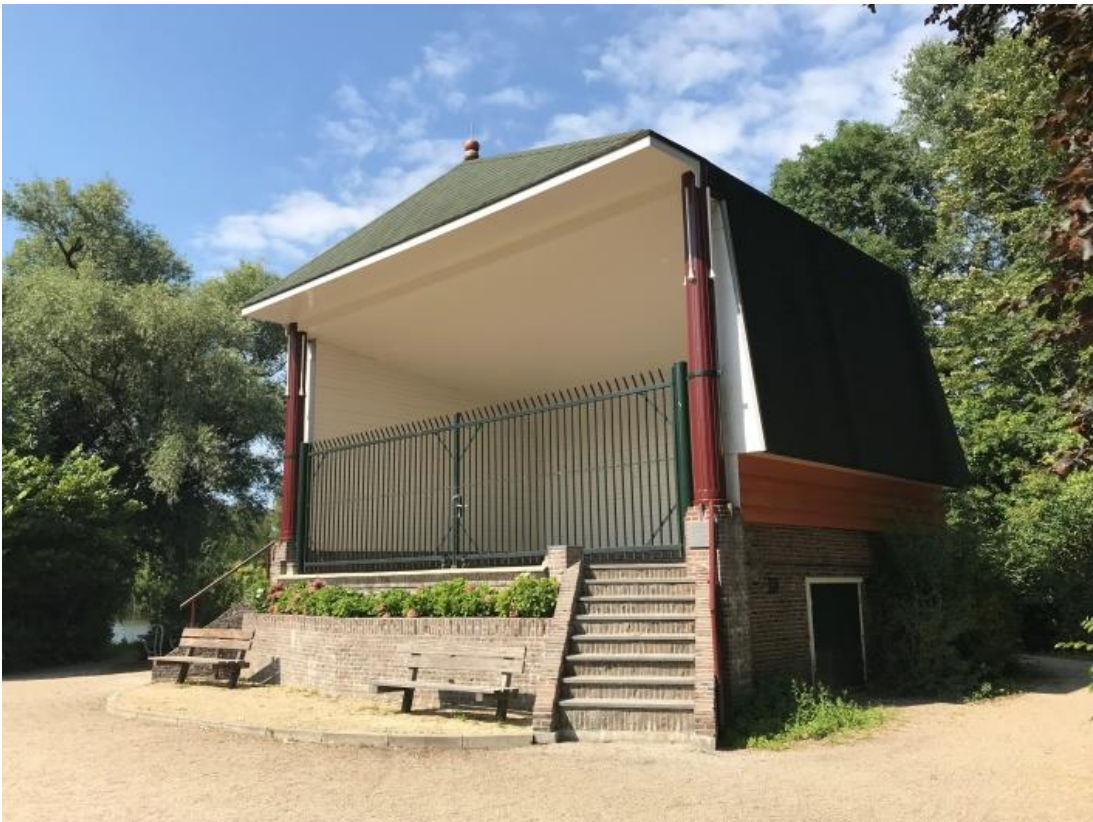
Zorgvuldig ontworpen en in stand gehouden muzikent met ingebouwde plantenbak, schuine trappen en Zaanse verschijningsvorm en detaillering, ontwerp bureau Granpré Molière, Verhagen en Kok, 1930.
