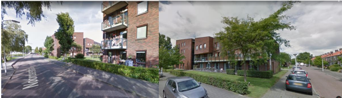
De appartementencomplexen gezien vanaf de Noorderstraat en Kortenaerstraat, 2018 [Google]
