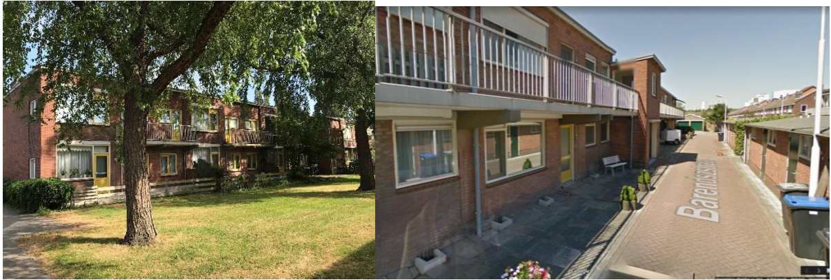
De groene binnentuin gezien vanaf de Kortenaerstraat, en het 'erf' in 2018 [Google]
