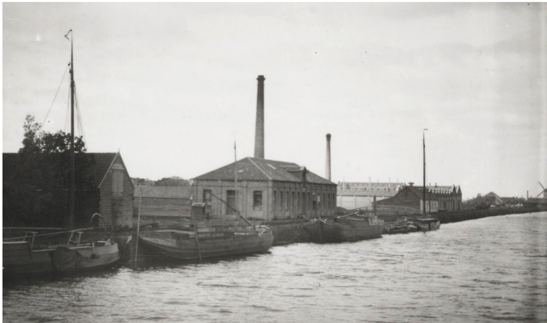
Circa 1900: Spinnerij aan de Vaardijk, met brug over de wegsloot. Bouwdatum onbekend maar voor 1888. Het aangebouwde ketelhuis aan de spinnerij (1910) is op deze foto nog niet gerealiseerd. Op de achtergrond zijn de fabrieken van de Verblifa zichtbaar.
