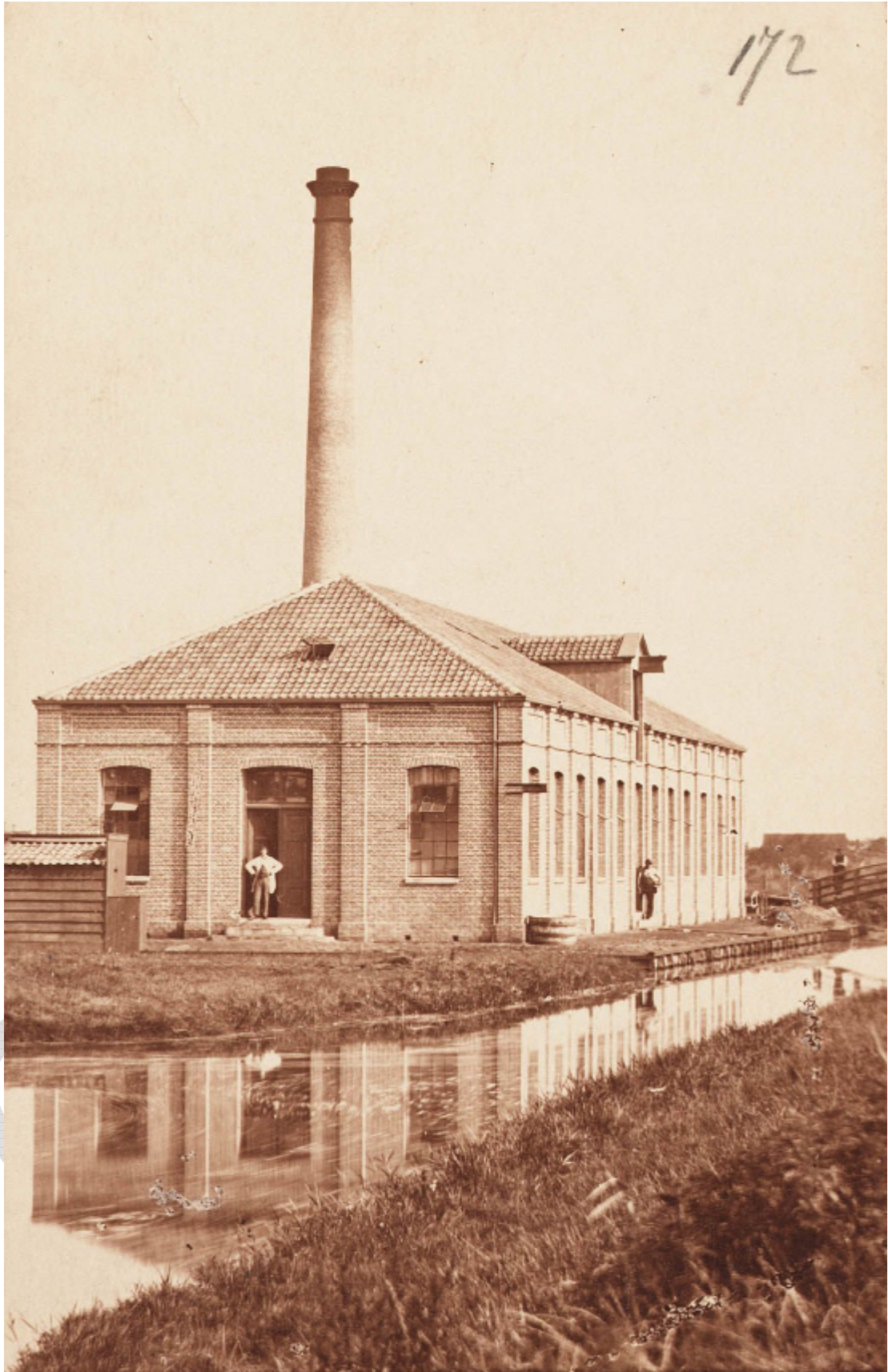
Spinnerij van de firma van Leyden circa 1900 GAZ 25.094.05563. Gezicht vanaf de Vaartdijk, destijds was tussen de dijk en de fabriekspannen de dijksloot nog aanwezig. Het terrein is bereikbaar via een houten brug.
