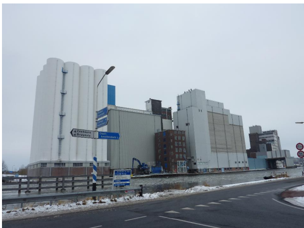
19. Van links naar rechts: silo Amerika (1964), silo De Koreenaar (1937), het voorreinigingsgebouw (1948) en silo Europa (1983-90)
