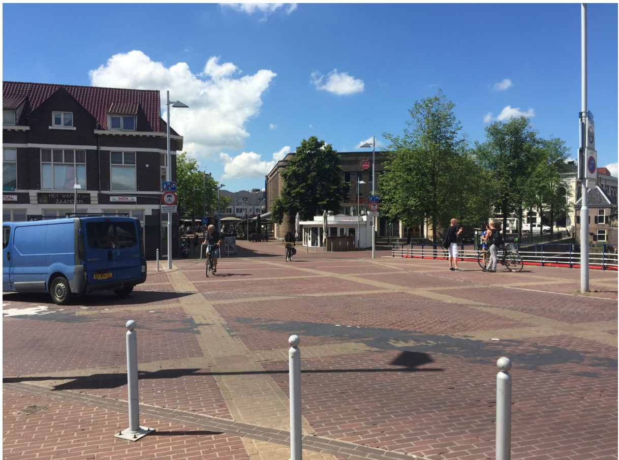
# Aantakking Wilhelminabrug aan de westzijde van de Zaan, kijkend richting de Damstraat. Onduidelijke scheiding van verkeersstromingen in het straatprofiel.
