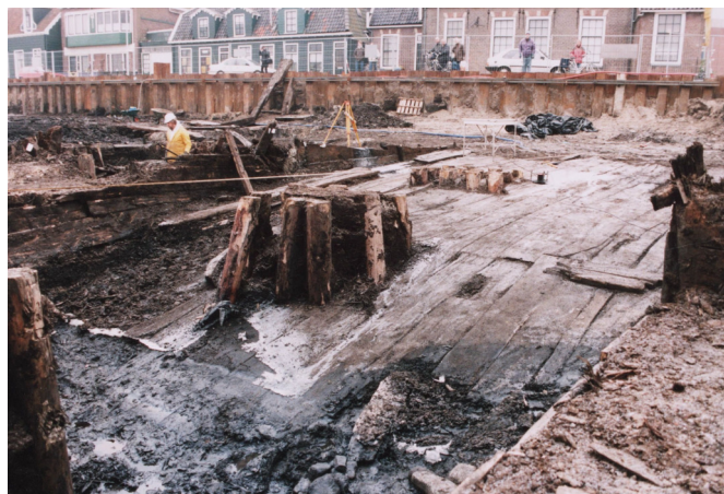
# De sloop van een 17e eeuwse werf langs de Hogendijk aan de Voorzaan. Op de achtergrond het monumentale woonhuis het 'Huis Cardinaelen'.
