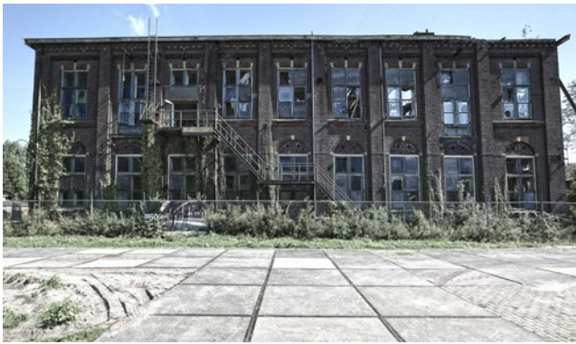
Gebouw 8, vóór restauratie, Hembrugterrein Zaandam
