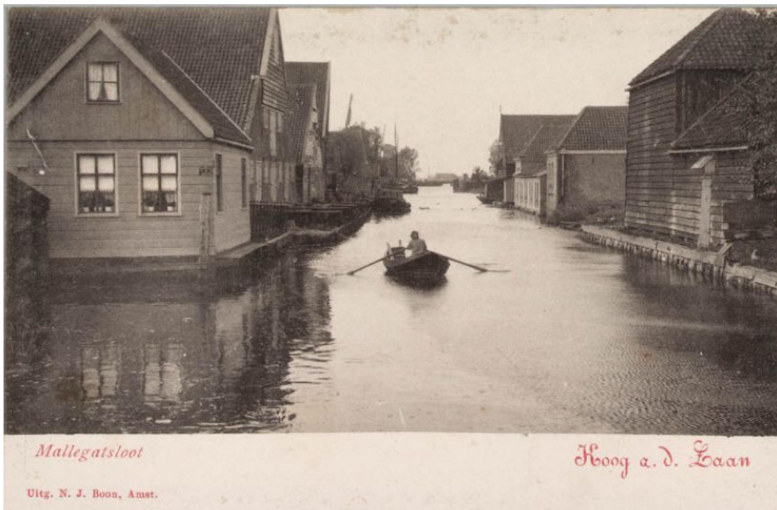
GAZ 41.00408 Mallegatsloot vanaf de sluis met rechts de Breedweer.
