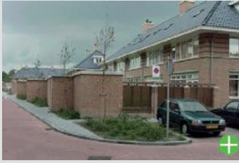
Goed geplaatste bijgebouw in passende vormgeving, materialen en kleuren
